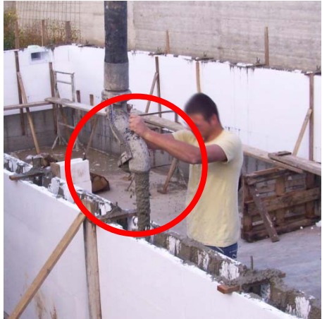
Getto del calcestruzzo con autobetoniera
