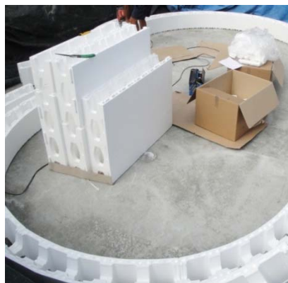
Posizionamento dei casseri
