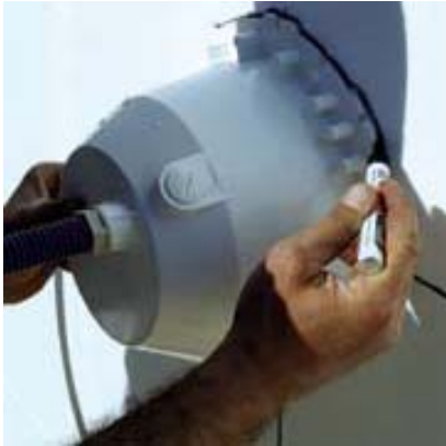
Tracciamento sul cassero del pezzo a murare
