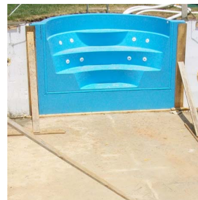
Controventatura della scala
