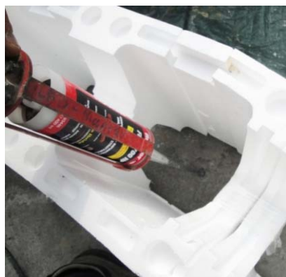
Applicazione ancorante chimico
