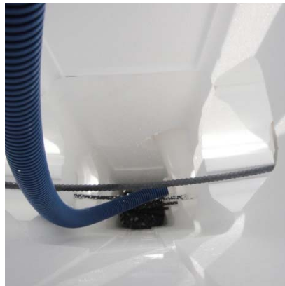
Completamento della posa del pezzo a murare
