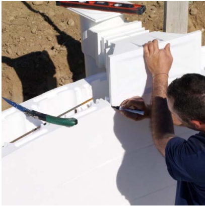
Tracciamento sul cassero del pezzo a murare
