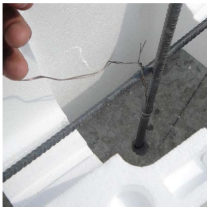
Legatura in trazione dell'armatura orizzontale e verticale
