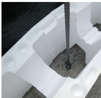
Posa delle barre d'armatura verticale
