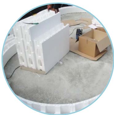
Blocchi TERMOMODUL Chiavette di curvatura e tamponamento
