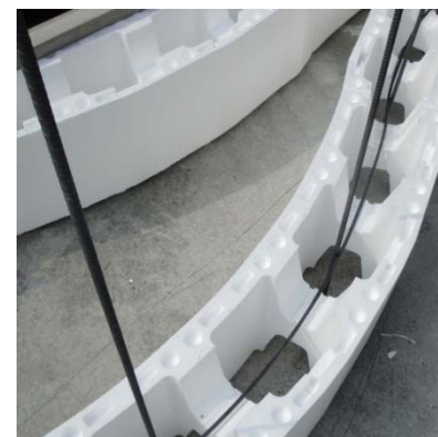
Posa dell'armatura orizzontale
