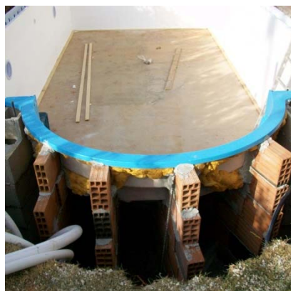
Posa della scala
