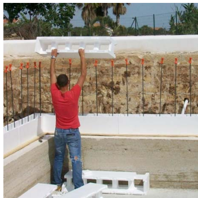
Completamento della linea di corso con i casseri
