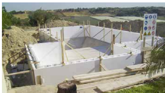
Operazione di controventatura dei casseri TERMOMODUL
