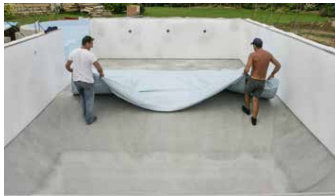
Stesura del liner all'interno della piscina
