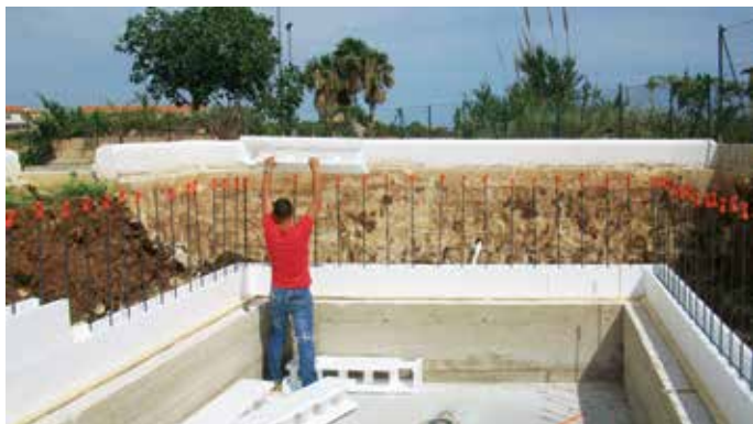
Posa della linea di corso con i casseri ISOBLOK
