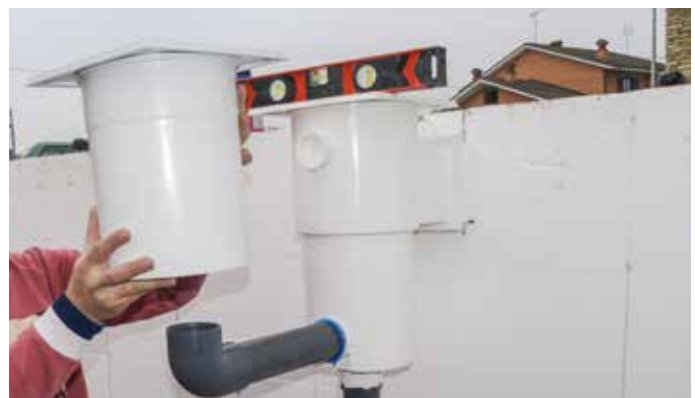
Assemblaggio del troppo pieno
