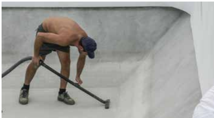
Pulizia della vasca prima della stesura del liner
