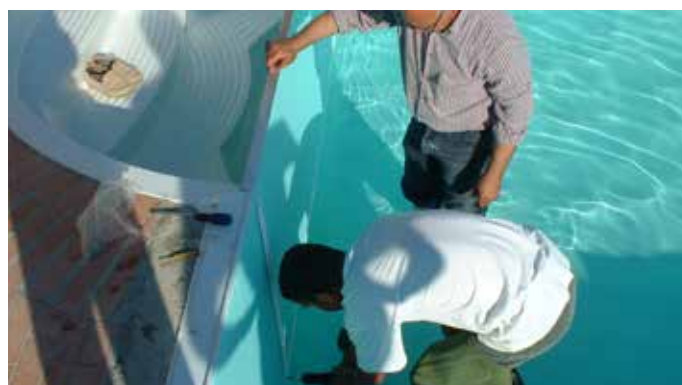
Fissaggio dei pezzi speciali - scala in vtr
