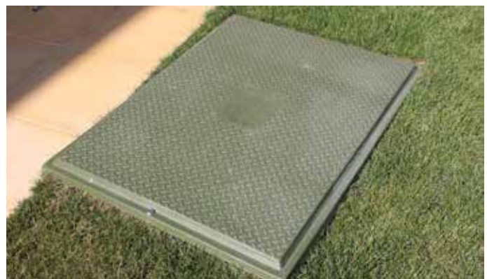
Locale tecnico interrato
