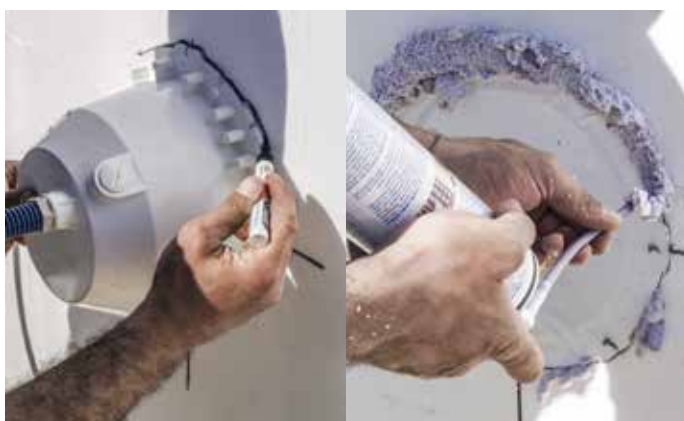
Posizionamento pezzi a murare, tracciamento e schiumatura
