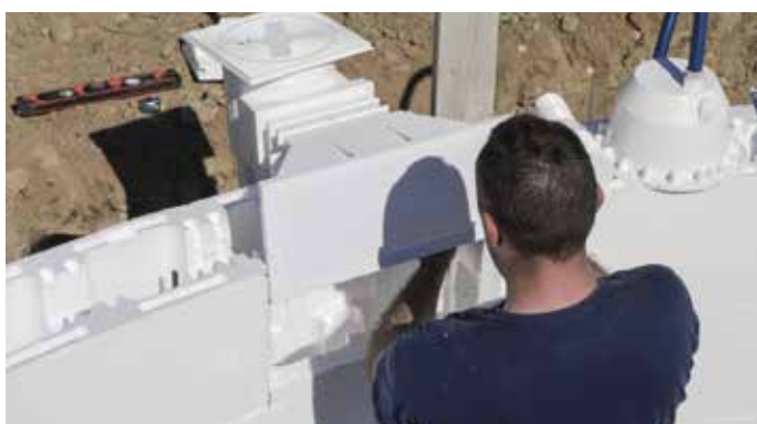
Posizionamento pezzi a murare (inserimento sagoma)
