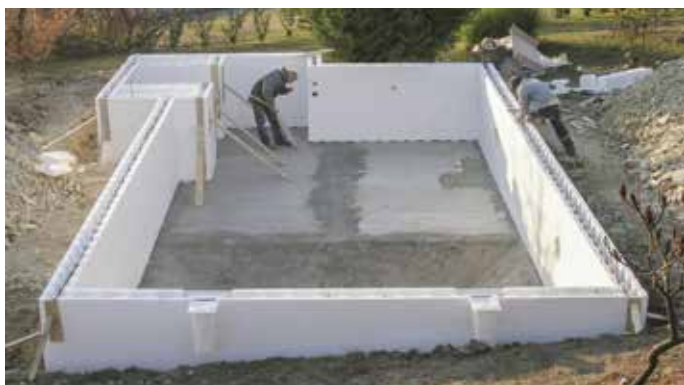
Completamento delle pareti con i casseri TERMOMODUL
