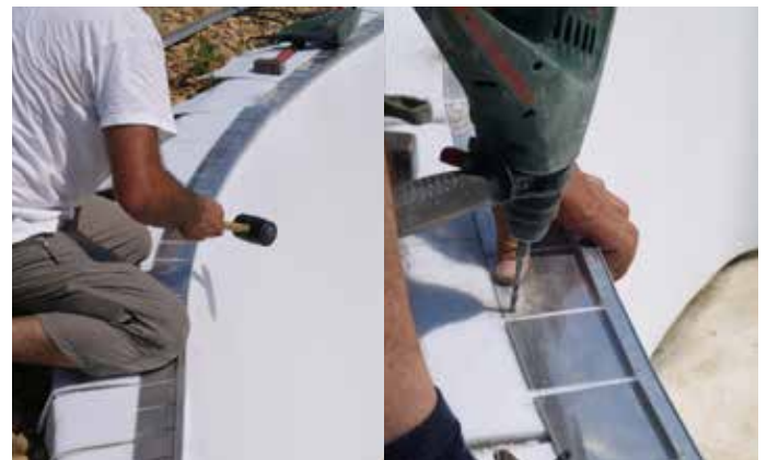
Operazione di posa e fissaggio della guida in alluminio
