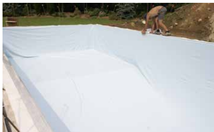
Fissaggio del liner alla guida
