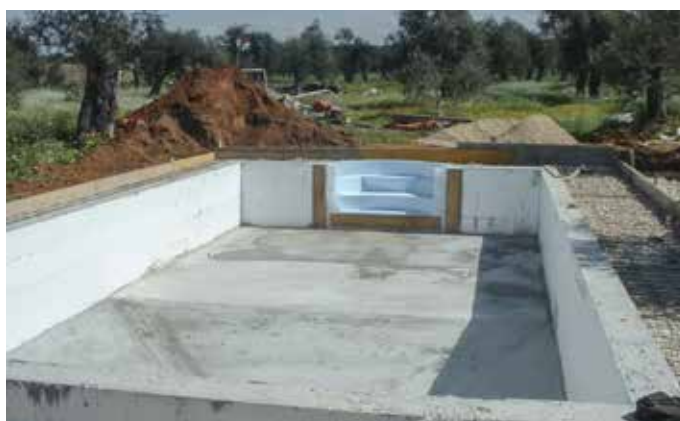
Getto di cemento completato
