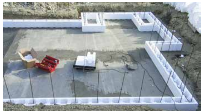
Posa dell'armatura verticale
