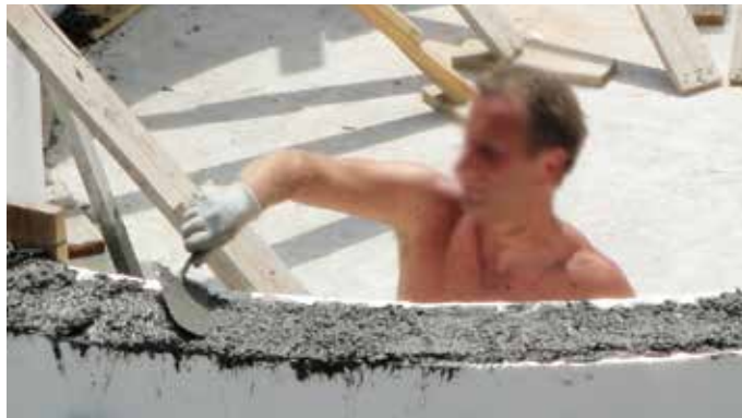
Livellamento della superficie
