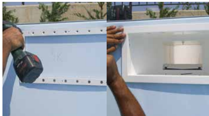
Fissaggio dei pezzi a murare
