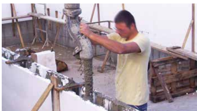
Getto del calcestruzzo
