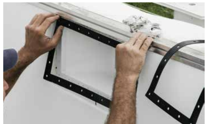
Posa delle guarnizioni degli accessori
