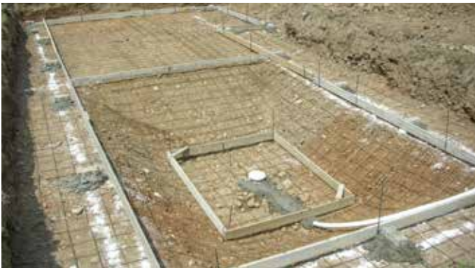
Stesura delle reti elettrosaldate
