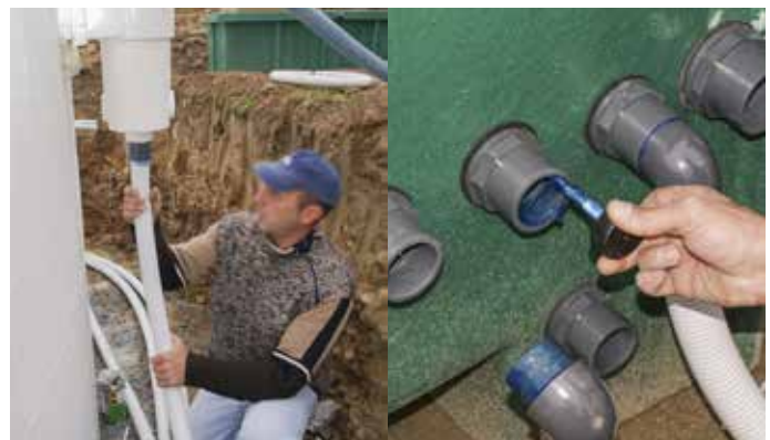
Collegamento idraulico dei pezzi a murare
