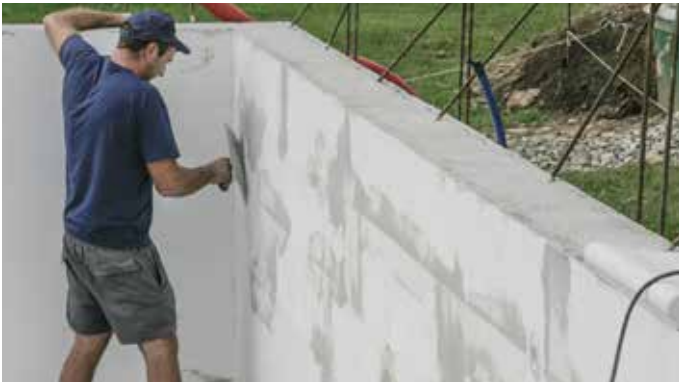
Stuccatura delle imperfezioni sulle pareti piscina
