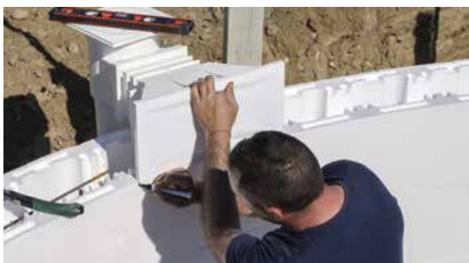
Posizionamento pezzi a murare (tracciatura sagoma)
