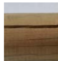
Cracks/Grietas/Fente/Risse/ Crepe/ Barsten/Fendas
